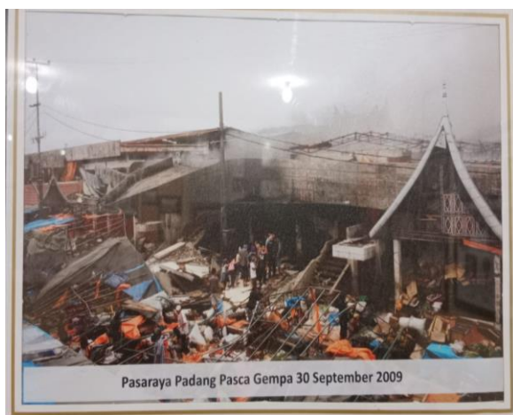
Gambar 3. Keadaan Pasar Raya setelah Gempa 2009
