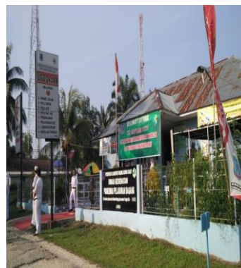
Gambar 8. Tampak depan Puskesmas Pelabuhan Dagang
