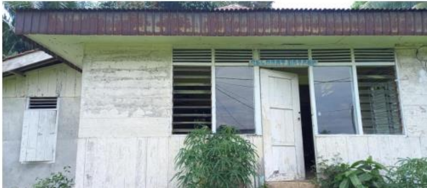
Gambar 3. Kantor Pencetakan Uang ORIPS di Dusun Rantau IKIL
