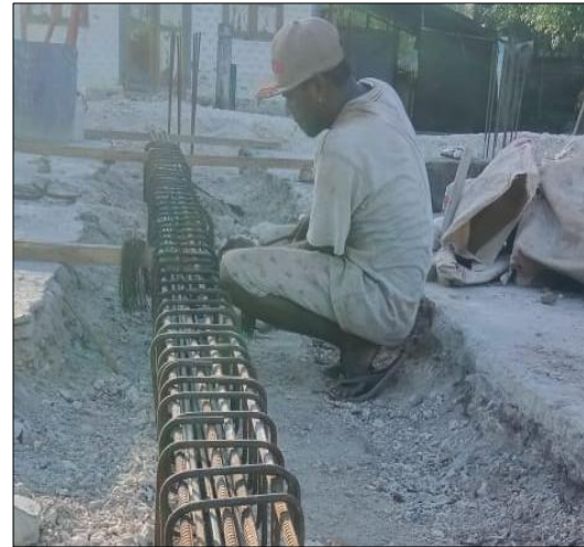
Gambar 4. Penulangan beton (Jauply, 2025)
