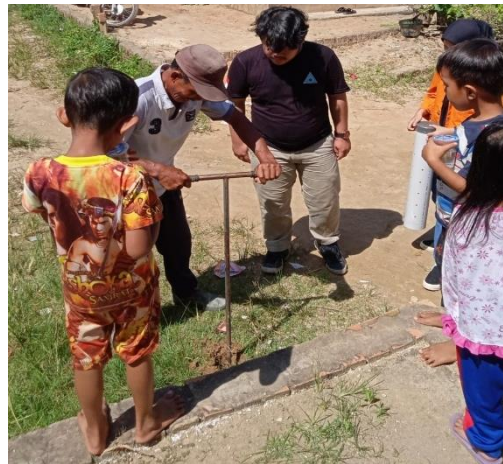
Gambar 2. Pelatihan dan penerapan lubang resapan Biopori
