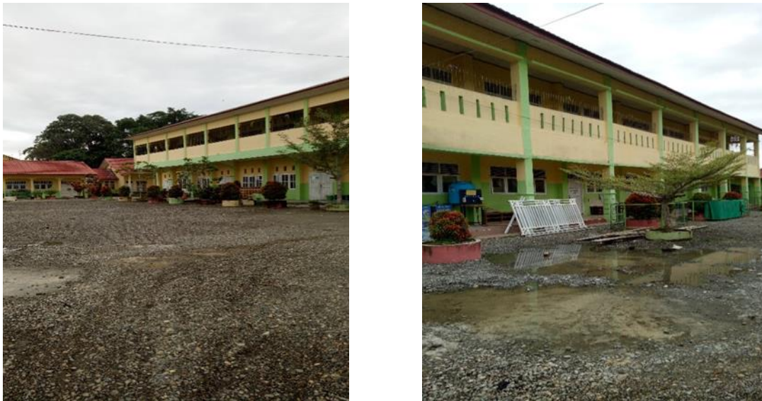
Gambar 1. Kondisi Eksisting SD IT Teuku Umar Meulaboh
