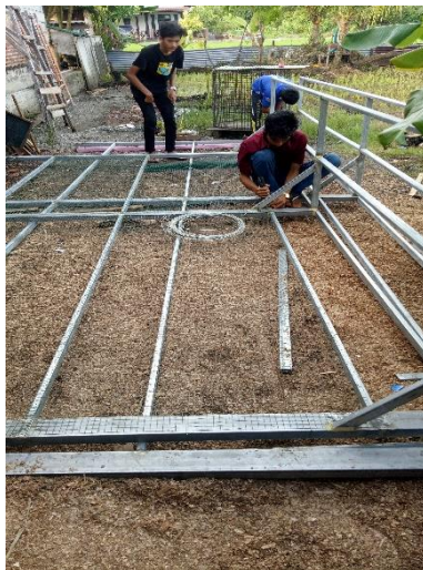
Gambar 7. Proses membuat rangka Vertical Garden yang dilakukan pada lokasi lain
